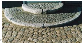
Mosaiksten lagt i trappe m/Radiussten
